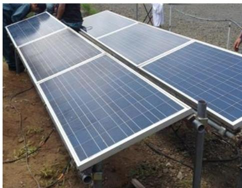
写真7 プレハブ横に太陽光発電用パネルを設置し電源を確保した (120W×6枚)
