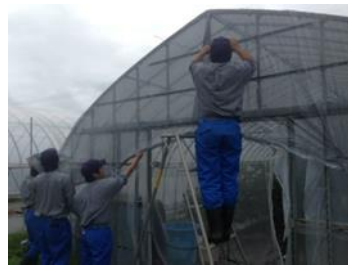
写真23 寒冷紗の設置
