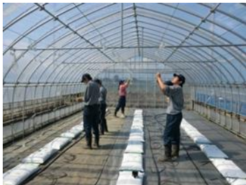
写真22 誘因ワイヤーの設置
