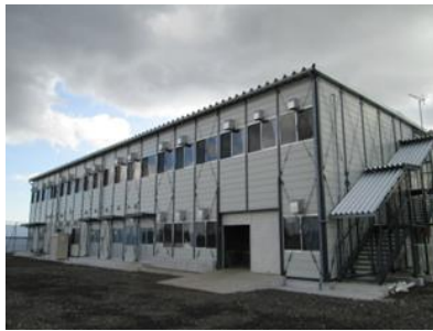
写真6 仮設農場管理棟
