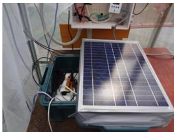
写真 38 ソーラーパネルの設置
